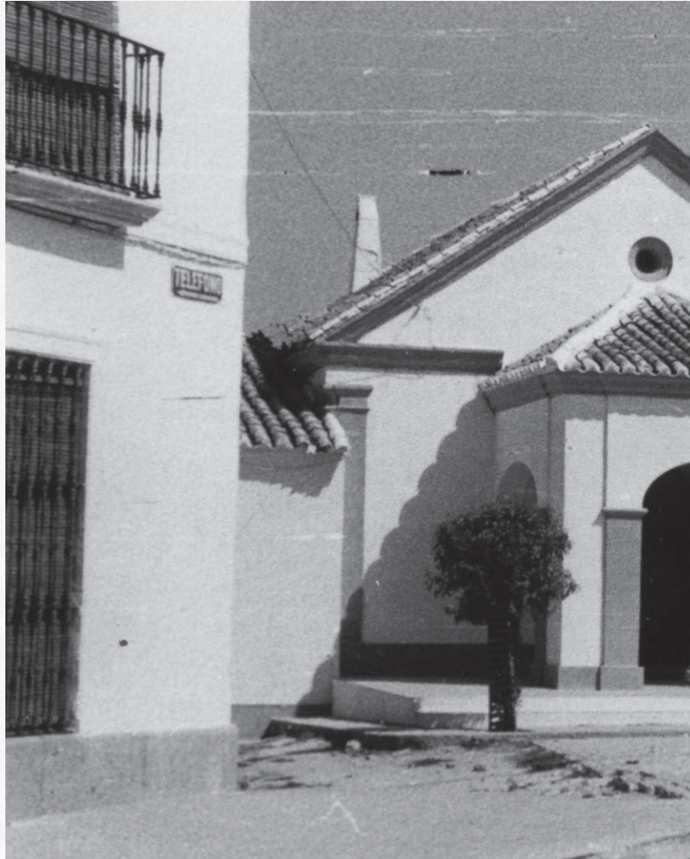
Rótulo TELÉFONO calle Bartolomé Valenzuela (actualmente calle Federico García Lorca).
